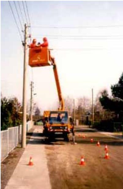
**Bild:** Bei Arbeiten an unter Spannung stehenden Freileitungen sind die erforderlichen Schutzausrüstungen einzusetzen.
